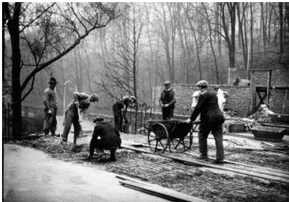
Práce na stavbě sborového domu
